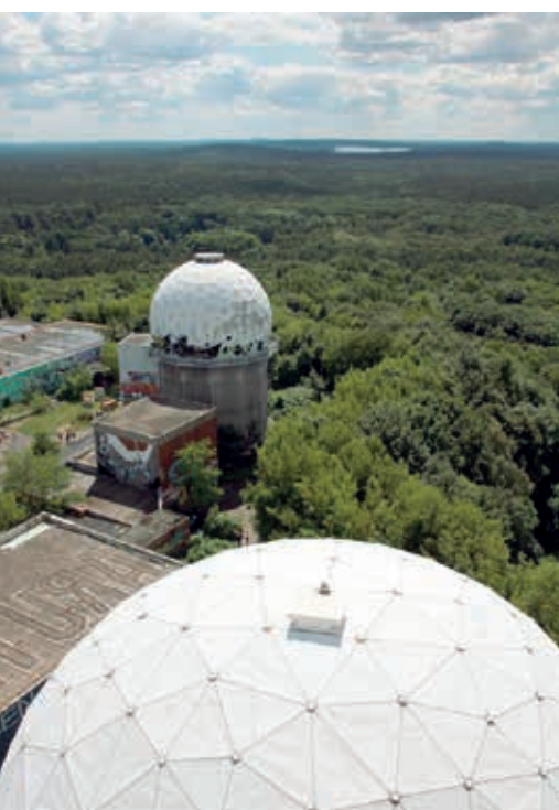
Ruinen des NSA-ECHOLON-Programms auf dem Berliner Teufelsberg: Weltweite Überwachung elektronischer Kommunikation
