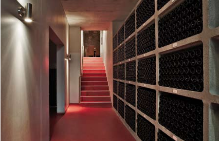
Neue Kelleranlagen unter der Hofterrasse
