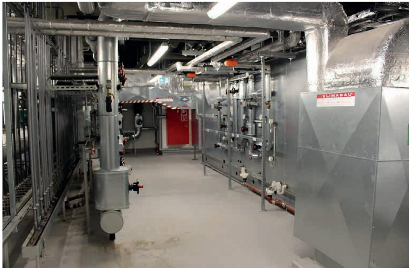
Kälteraum unter der Hochschule – hier ist eine beispielhafte Kältemaschine zu sehen, die im ersten Konzept zur Deckung der Spitzenlasten genutzt wird
