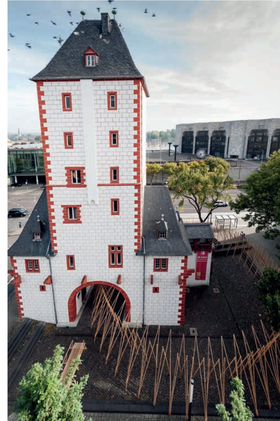
Nach der Realisierung: Eine filigrane Struktur aus fünf Meter hohen Holzlaten mit einem Durchmesser von 20 Metern akzentuiert den Platz
