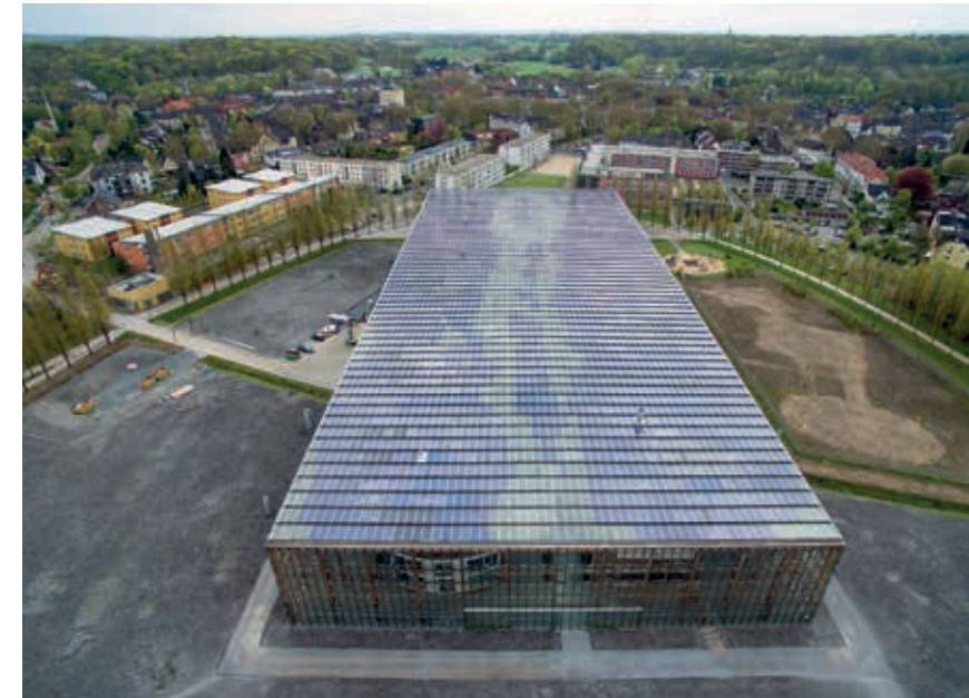
Fehlgeschlagene städtebauliche Einbindung: Mont Cenis, das neue Stadtteilzentrum von Herne-Sodingen, wirkt wie ein Fremdkörper in der Umgebung
