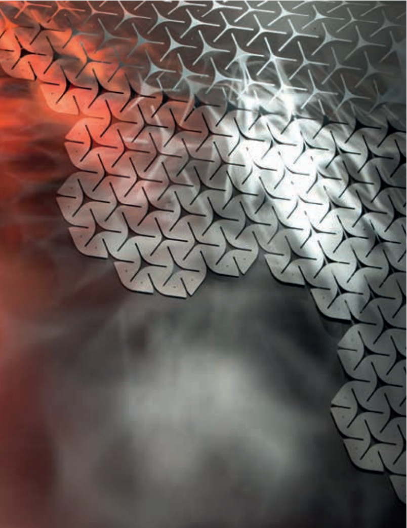
Die dreidimensional geformte, aus Metallpanelen gefertigte „Wolkendecke“ wurde aus einzelnen Modulen zusammengesetzt
