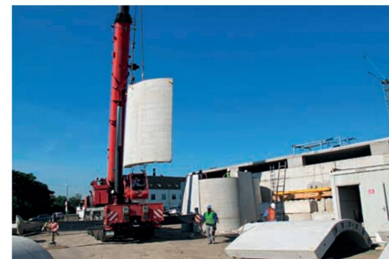
Das Modulkonzept erleichtert auch den Transport und die Montage der Fertigteile, die künftig dezentral produziert werden können
