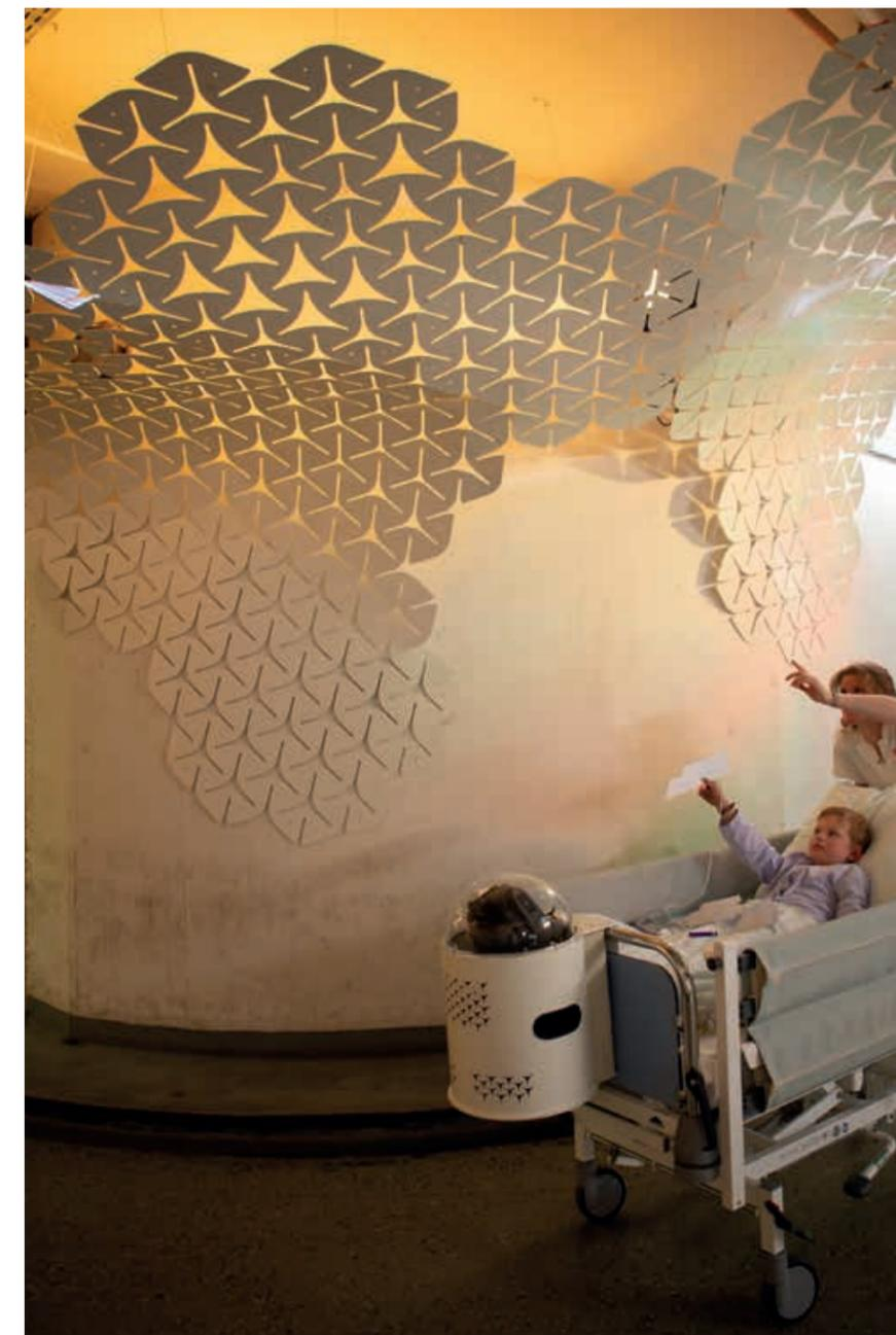
Dreidimensional verformbare Deckenpanels aus gelaserten Aluminiumplatten bilden eine „Wolkendecke“, auf der ein stilisierter Papierflieger dem Bett voraneilt
