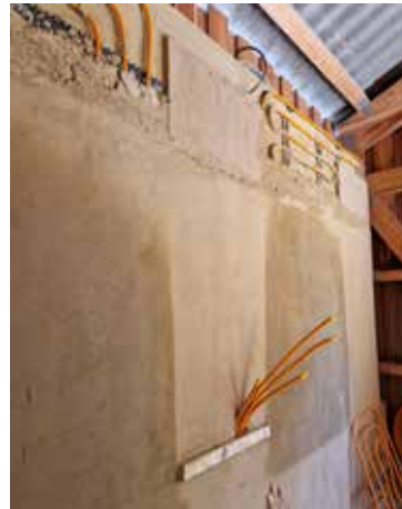
Bei Neubauten eignet sich Lehm bestens für Wandheizungssysteme.
