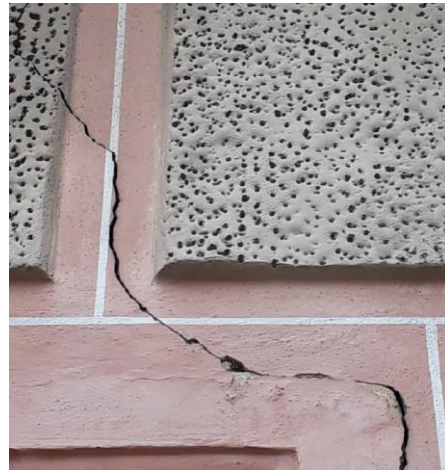
Riss in der Fassade
