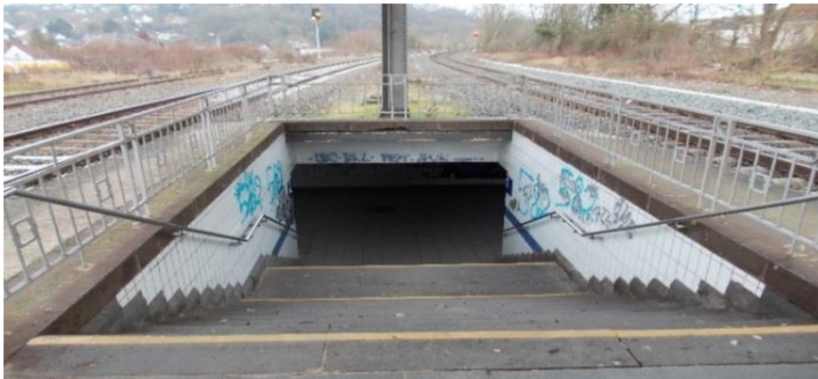
Die Fotografien zeigen den in erheblichem Umfang sanierungs- und modernisierungsbedürftigen Bahnhof Diez. Ein konkreter Realisierungshorizont für planerische Überlegungen zur Herstellung der Barrierefreiheit wurde dem Rechnungshof nicht genannt.
