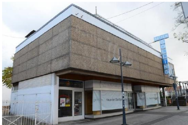
Sanierungsbedürftige Fassade des ehemaligen Kaufhauses
