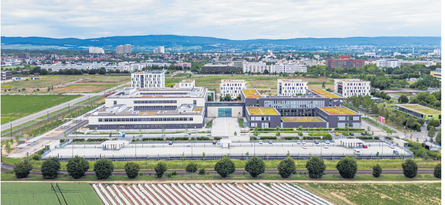
Der Campus der Hochschule Mainz dient auch als Reallabor für die Forschung für einen datenbasierten Gebäudebetrieb.
