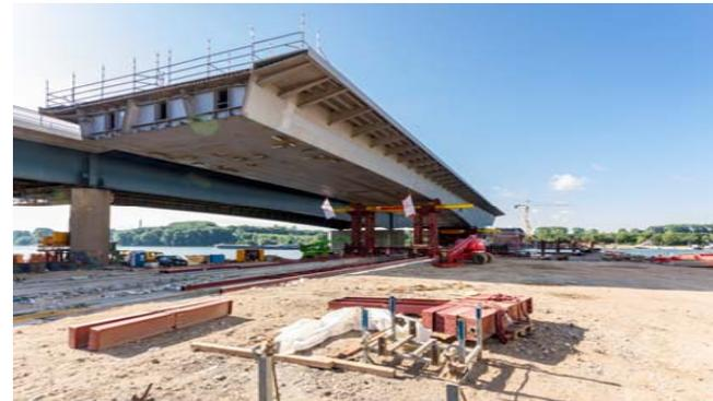
Die Firmengruppe Max Bögl errichtet in einer ARGE mit dem Ersatzneubau der Schiersteiner Brücke die längste Rheinbrücke Hessens. Der Vortrag geht auf die bautechnischen und logistischen Herausforderungen einer Wasserbaustelle mit Inselbetrieb ein. Im Fokus des Vortrags steht der Brückenvershub sowie das Einschwimmen der Brückenabschnitte.
