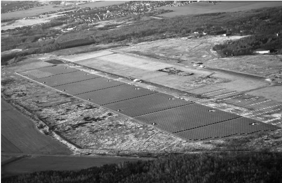
Abb. 3: Stand der Bauarbeiten Ende Januar 2008, rund 9 Monate nach Baubeginn
